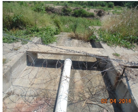
b. Discharge point
